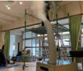
■工場内施工中
